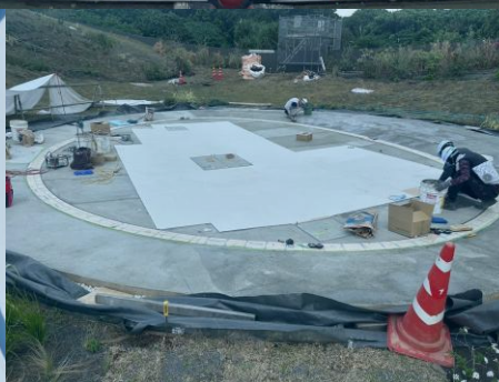
緩やかに弧を描く階段は、タイル割り付けにも細やかな工夫を行う【NAH石垣HPブログから】
