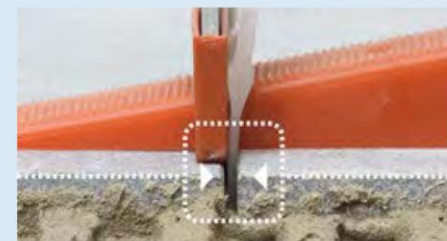
■ADクリップ工法：クリップを締付けることで不陸（段差）を調整
